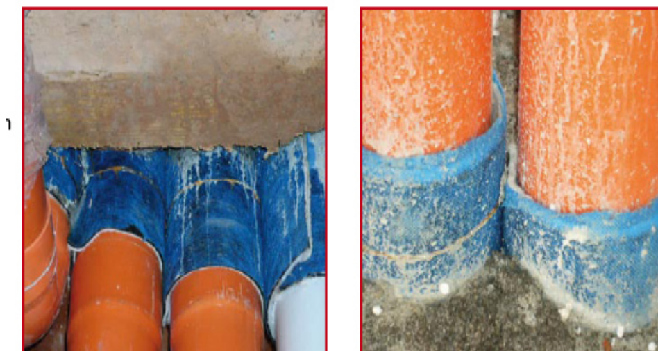
Particolare del rivestimento degli impianti nel passaggio attraverso i solai
