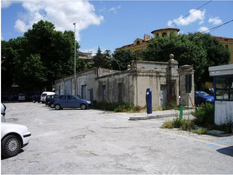
VEDUTA INTERNA VERSO NORD-EST
