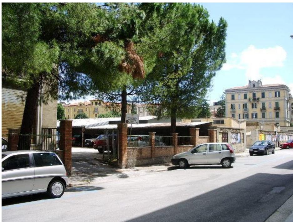
VEDUTA ESTERNA LATO SUD
