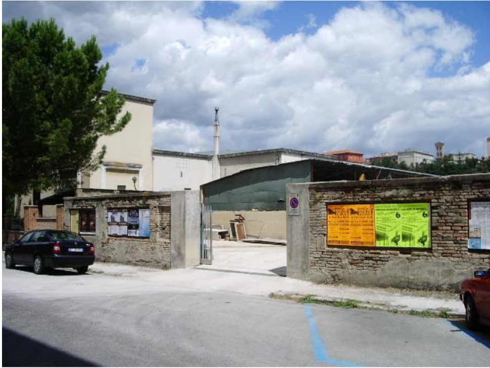
VEDUTA ESTERNA LATO SUD
