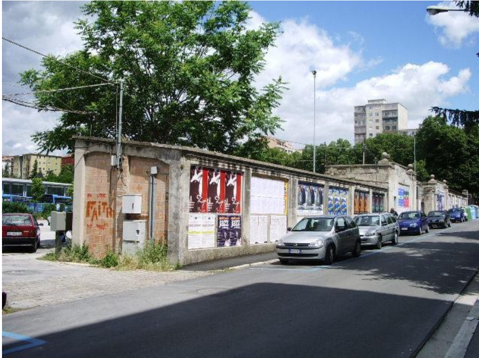
VEDUTA ESTERNA LATO EST
