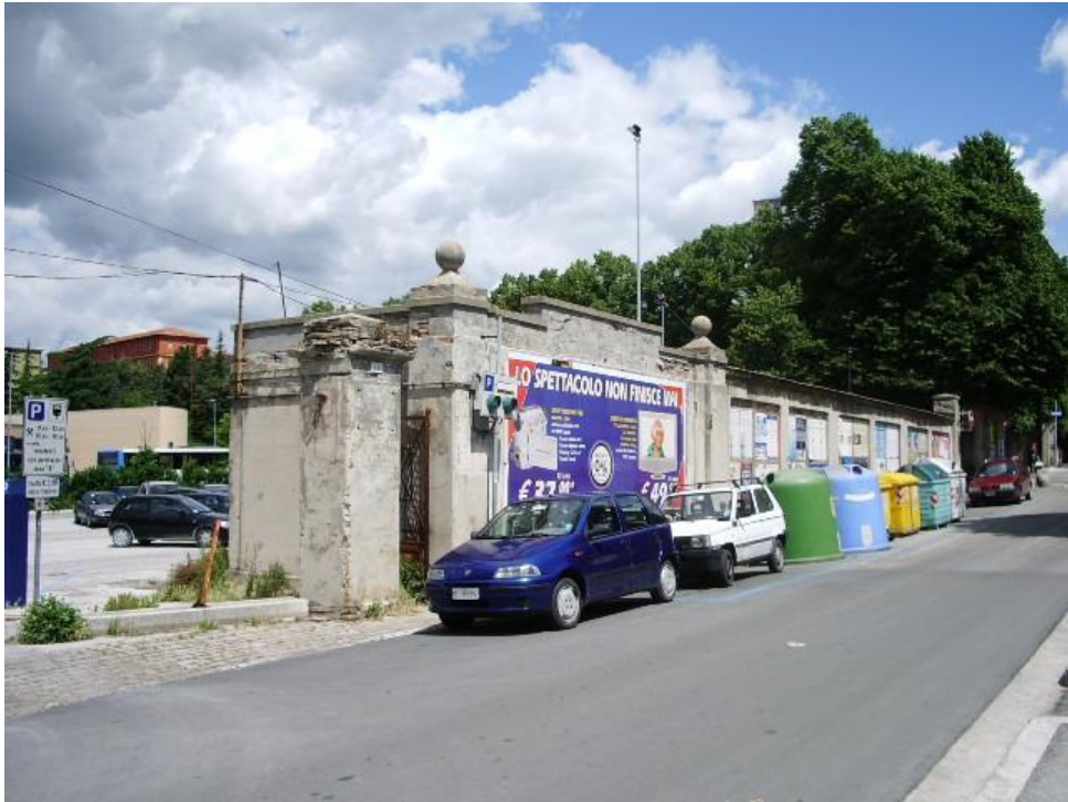
VEDUTA ESTERNA LATO EST
