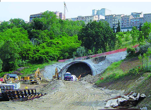
maggio 2004 fase iniziale imbocco nord ~ Fontezucca
