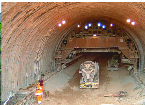
febbraio 2006 lavori all'interno della galleria
