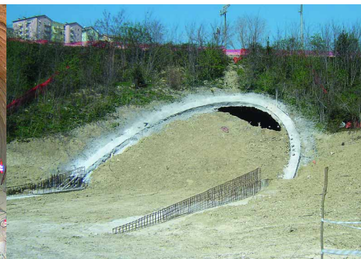
marzo 2007 apertura varco imbocco sud ~ Fontescodella
