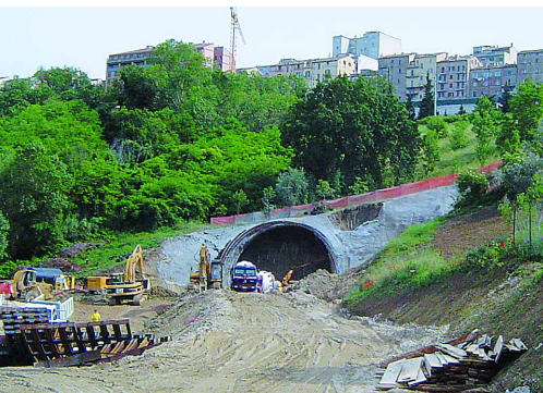
maggio 2004 fase iniziale imbocco nord ~ Fontezucca
