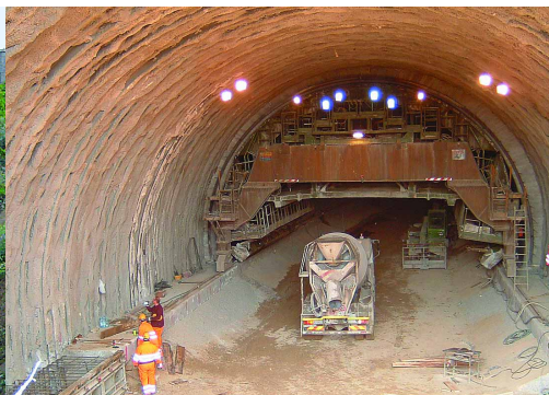
febbraio 2006 lavori all'interno della galleria
