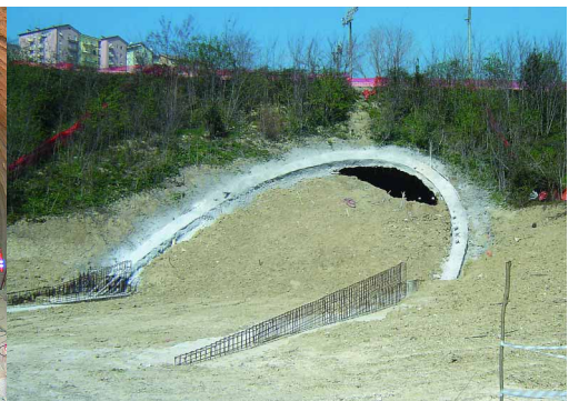
marzo 2007 apertura varco imbocco sud ~ Fontescodella
