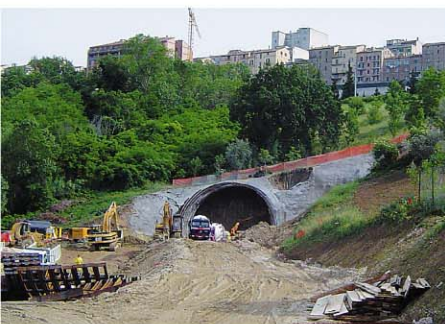
maggio 2004 fase iniziale imbocco nord ~ Fontezucca
