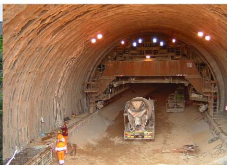
febbraio 2006 lavori all'interno della galleria
