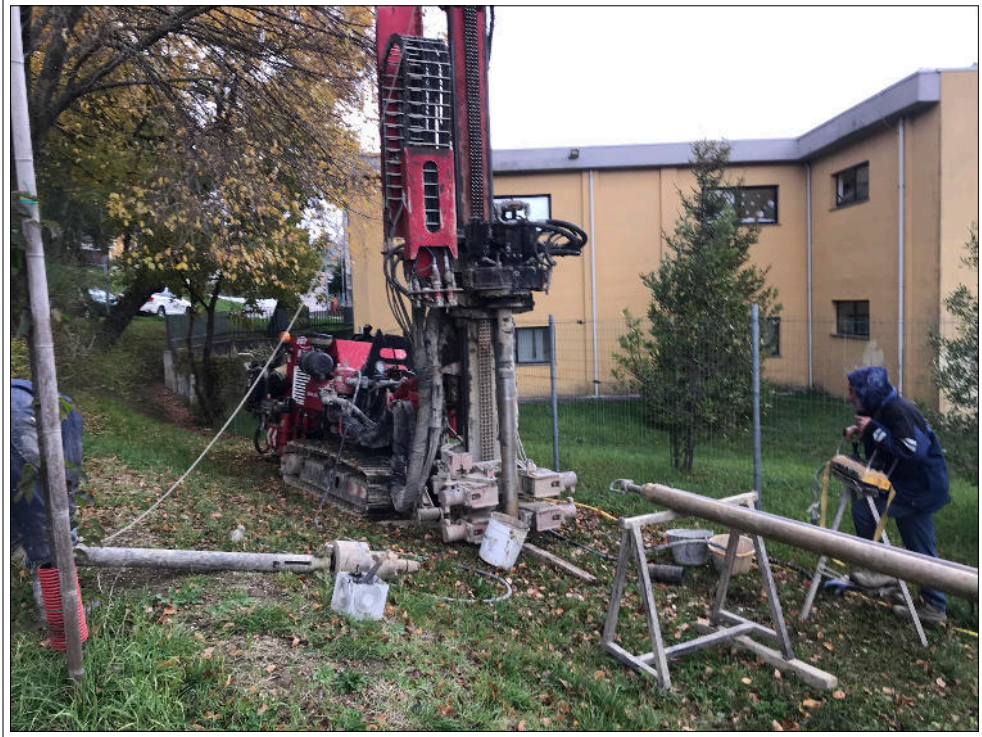
Foto n° 1 - Realizzazione sondaggio geognostico S1
