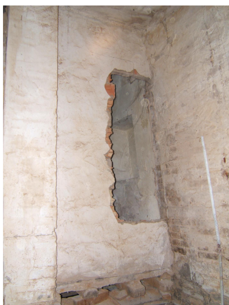
interno piano primo dal n° civico 67
