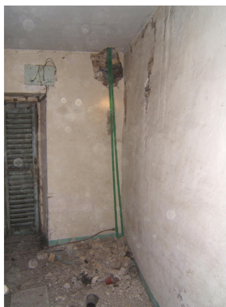
interno piano primo dal n° civico 67
