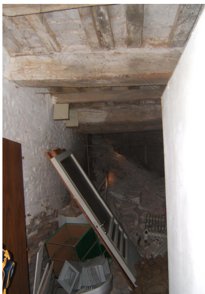
interno piano terra dal n° civico 69
