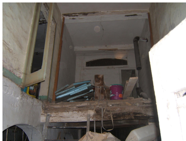
interno piano primo dal n° civico 67
