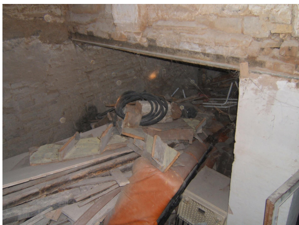
interno piano terra dal n° civico 67
