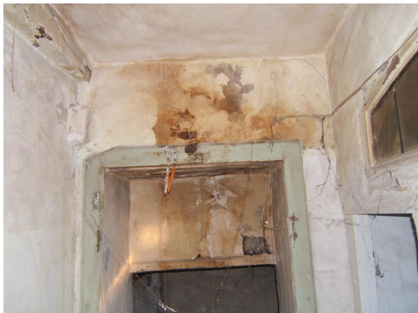
interno piano primo dal n° civico 65
