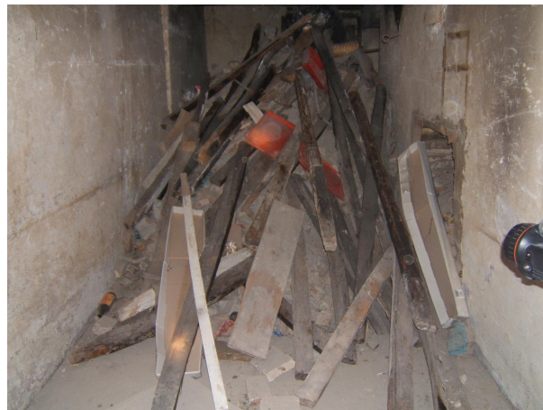
interno piano primo dal n° civico 65
