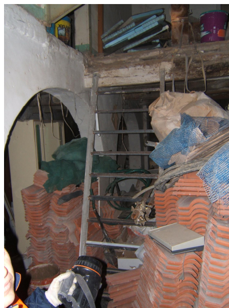
interno piano terra dal n° civico 67
