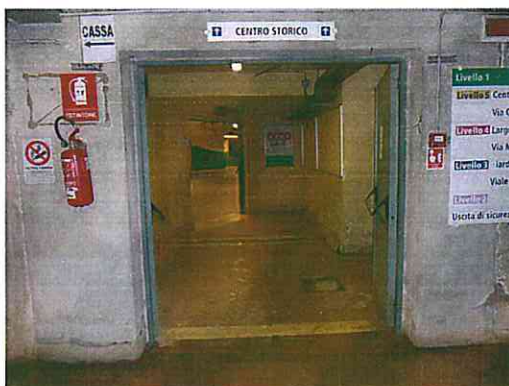
Accesso al tunnel dal Park Si
