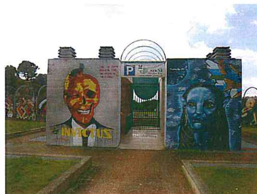
Ingresso meccanizzato dai Giardini Diaz
