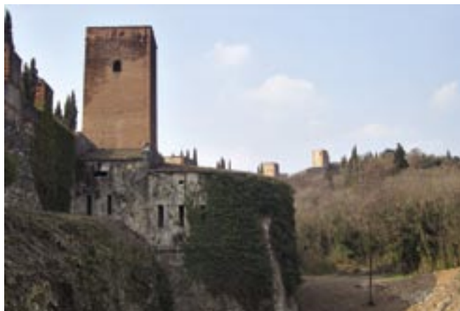
BATTERIA DI SCARPA
