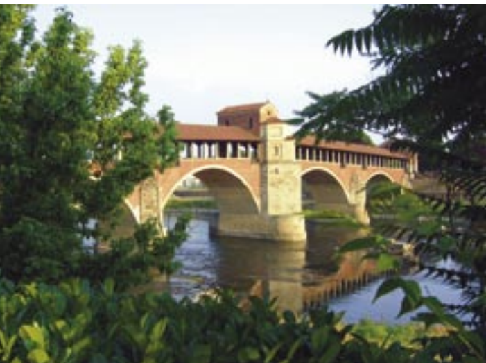
PONTE COPERTO VISCONTEO
