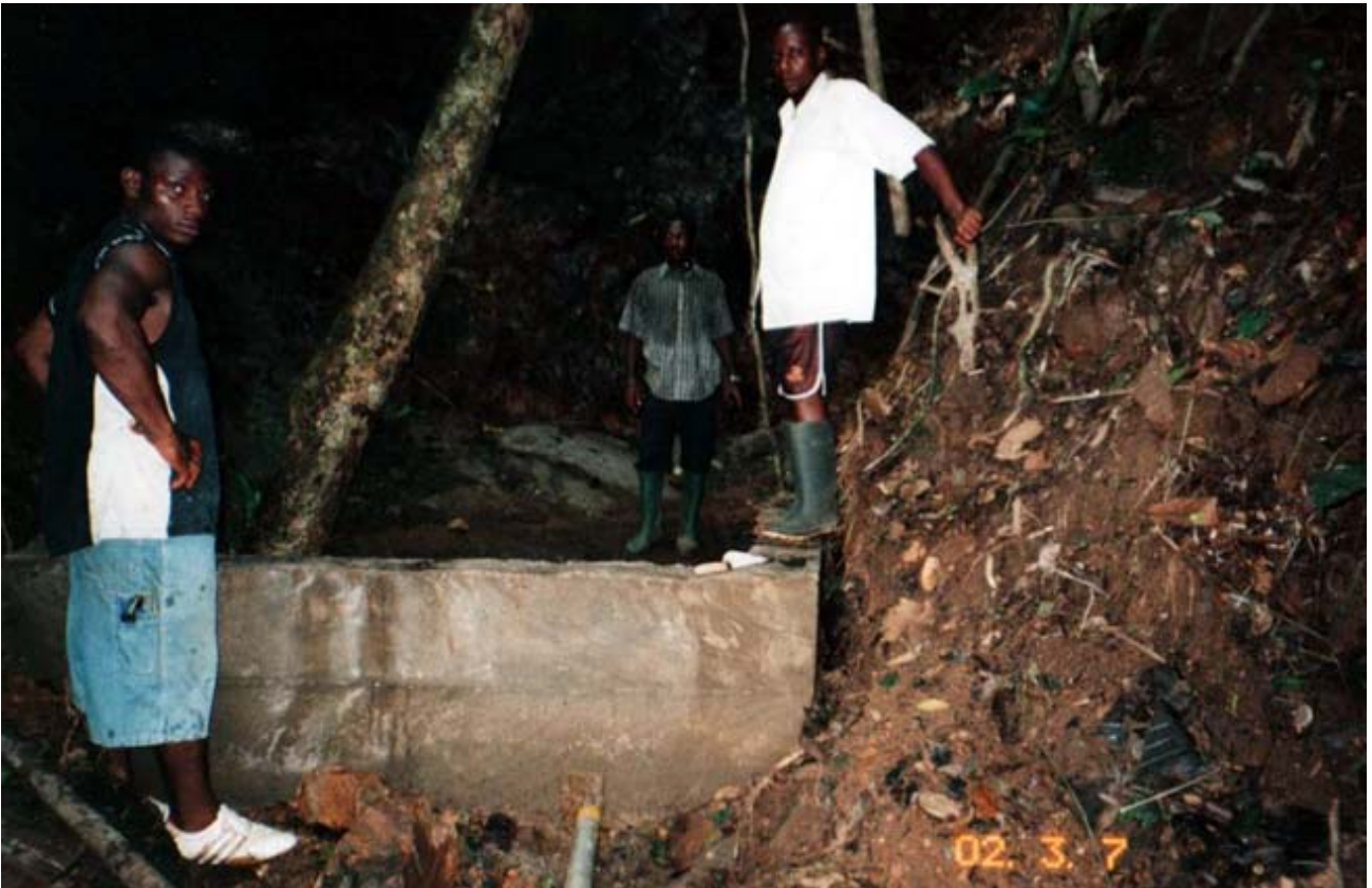
Primo bacino di raccolta dopo smontaggio cassaforma.
