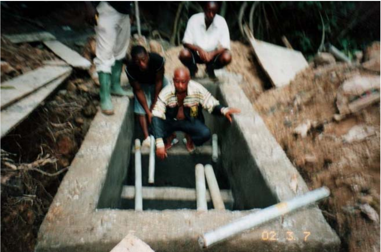
Struttura per la sedimentazione e la filtrazione dell'acqua, dopo smontaggio della cassaforma.
