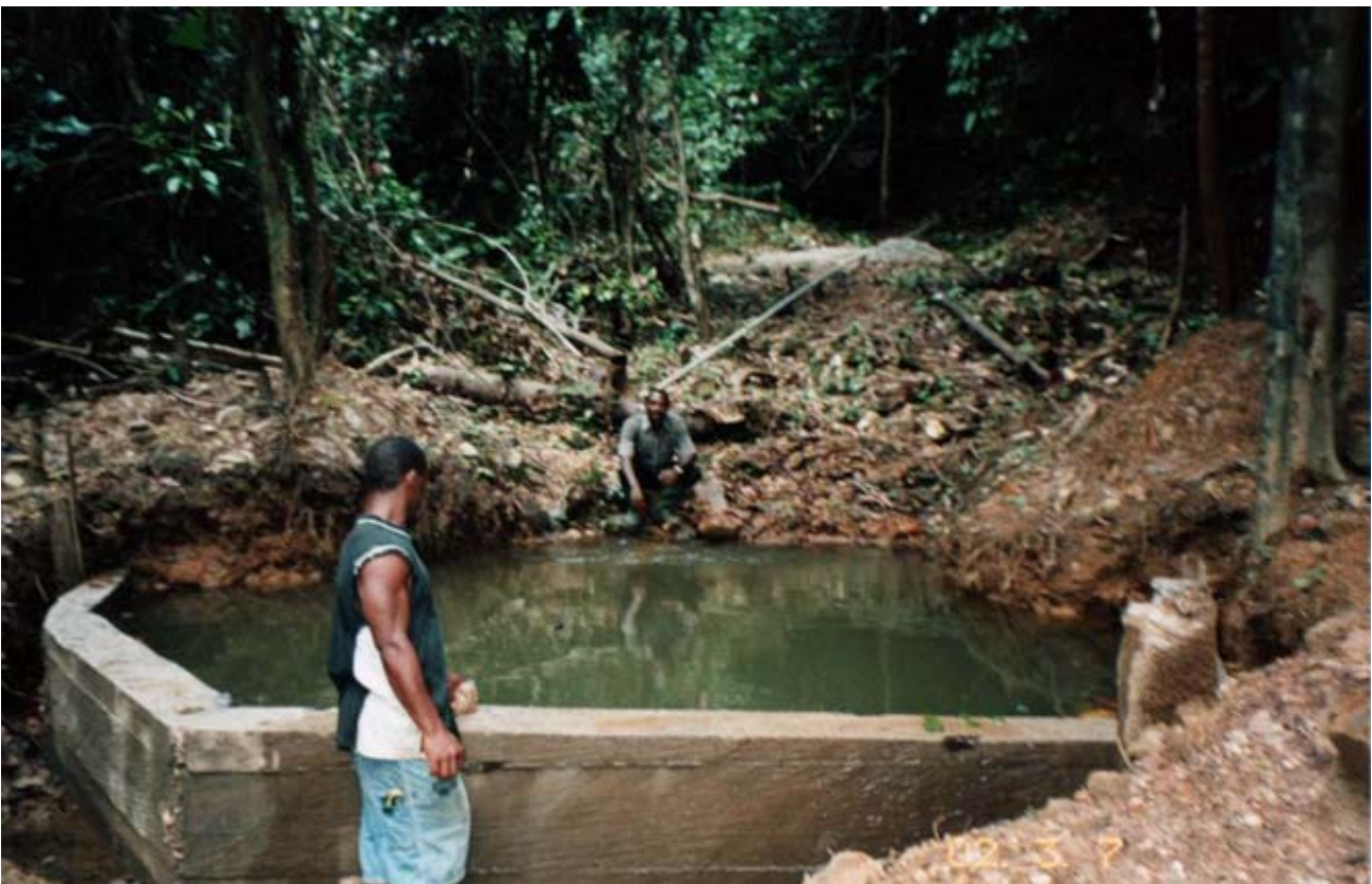
Secondo bacino di raccolta dopo smontaggio cassaforma.
