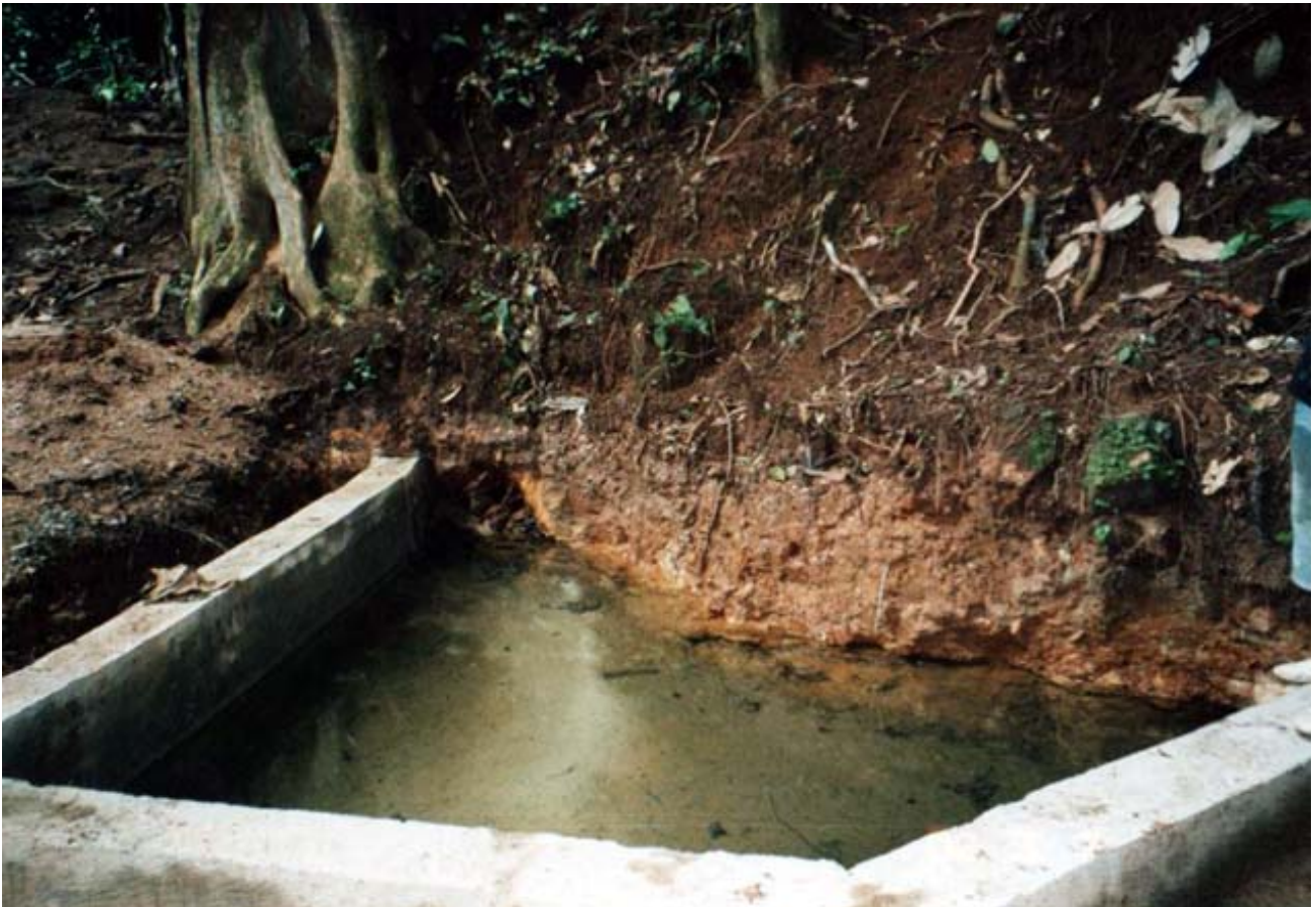
Terzo bacino di raccolta dopo smontaggio di cassaforma.
