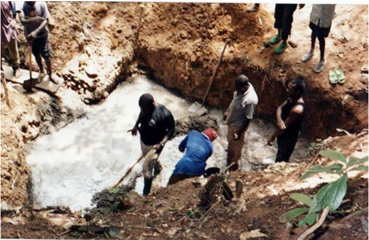
Terzo bacino: cementificazione della superficie.
