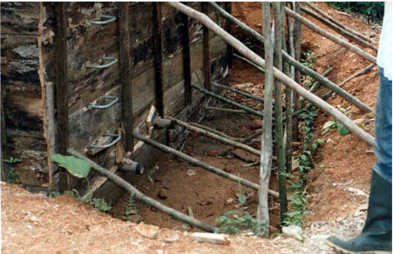
Particolari della cassaforma per la costruzione del serbatoio.
