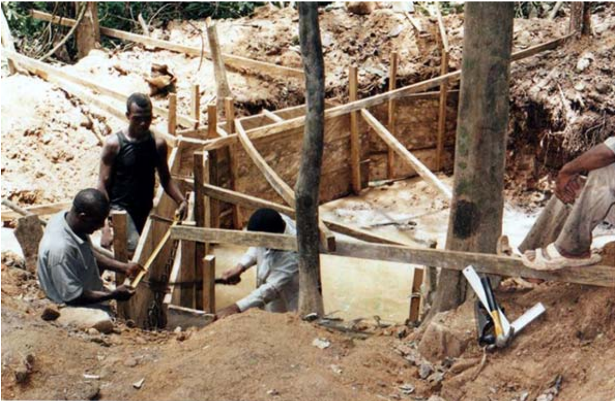
Secondo bacino di raccolta: Costruzione della Cassaforma.
