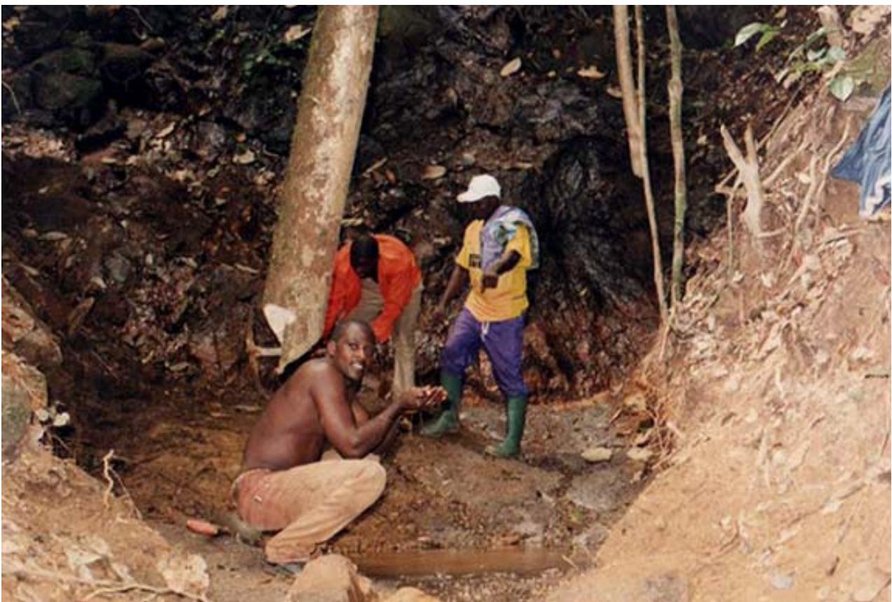
Primo bacino di raccolta dopo i lavori di scavo.
