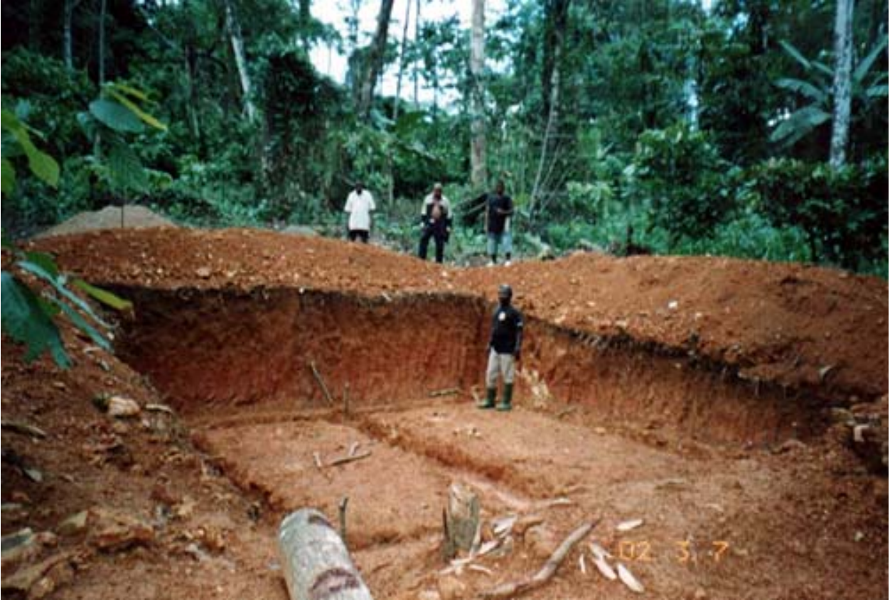
Scavo per realizzare il serbatoio.
