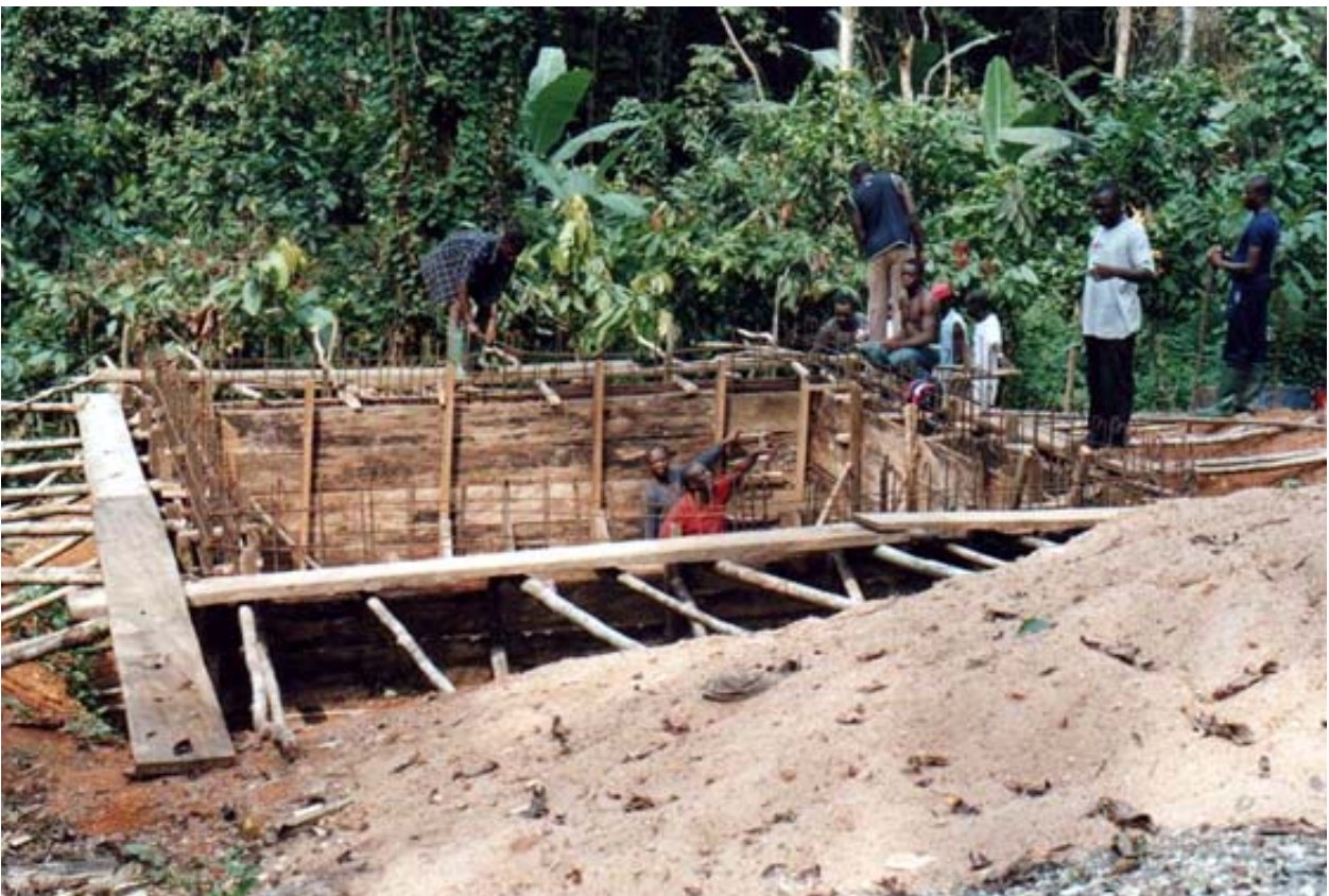
Serbatoio da 50 m cubi di capacità. Costruzione della cassaforma
