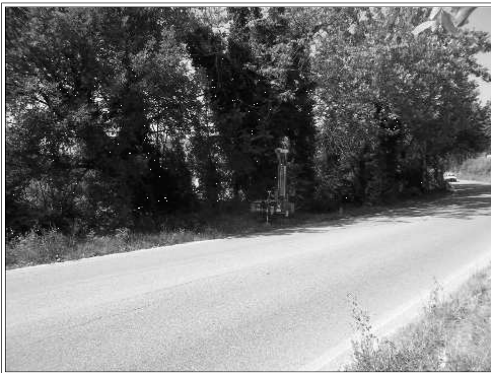
Foto n° 7 - Realizzazione prova penetrometrica Pp2
