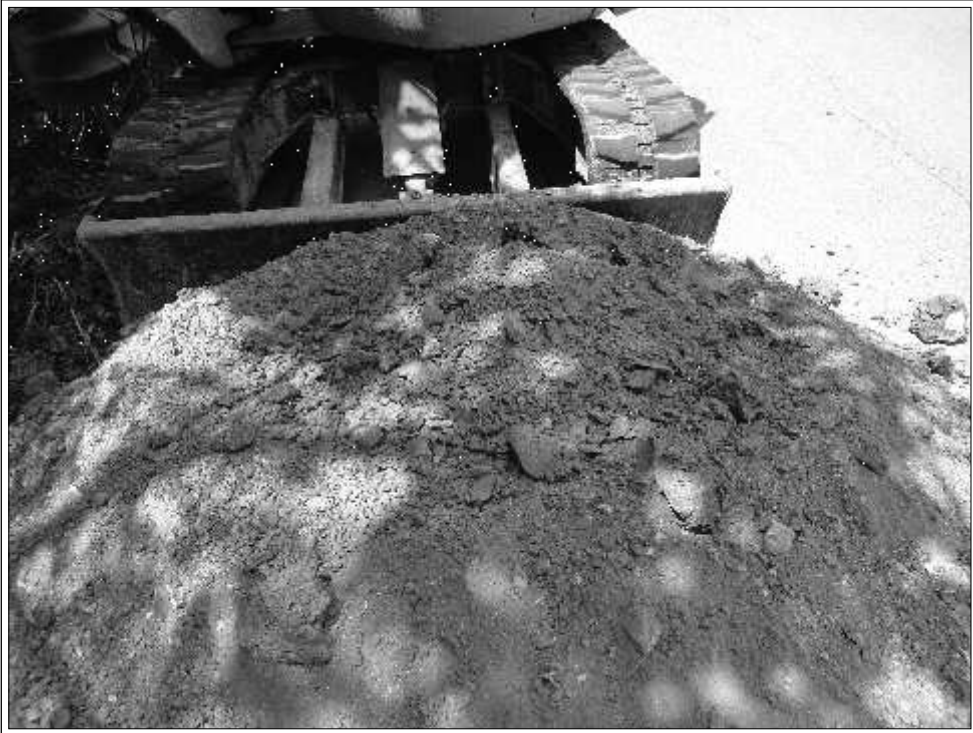
Foto n° 5 - Argille marnose e/o siltoso - marnose rinvenute a partire da 5,50 m
