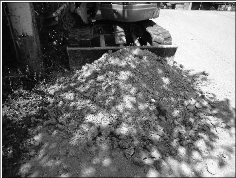
Foto n° 4 - Ghiaie in matrice sabbioso - limosa con ciottoli, rinvenute tra 3,10 m e 5,50 m
