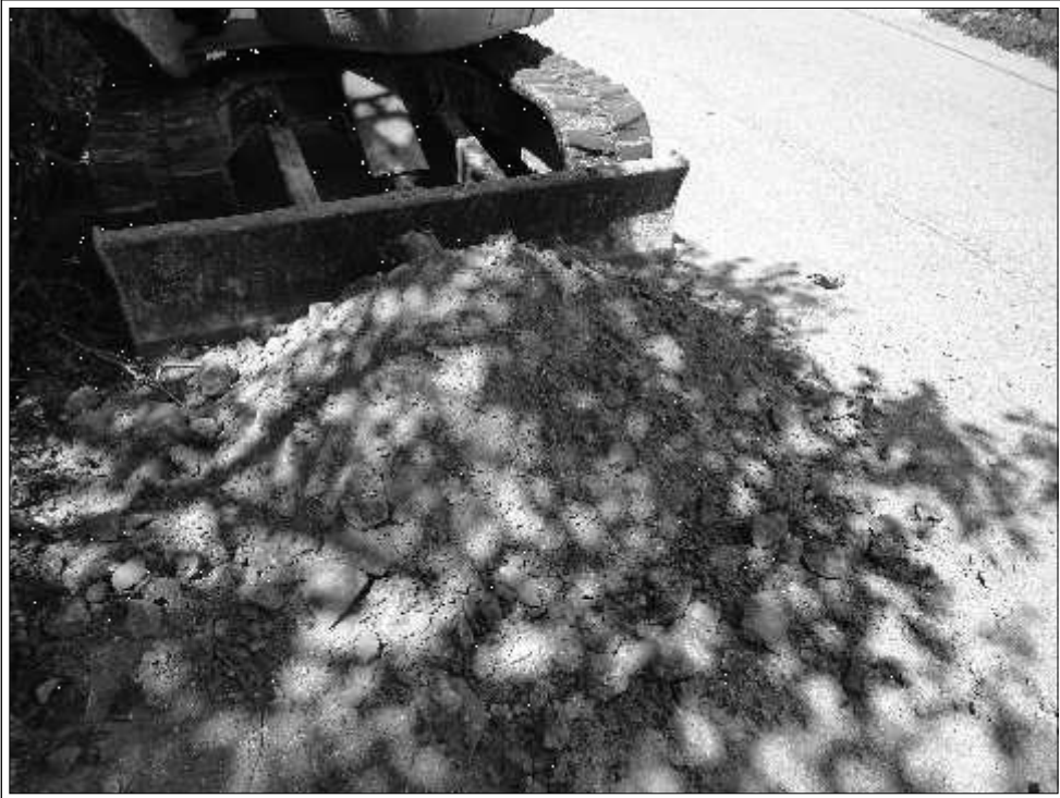
Foto n° 3 - Limi sabbiosi e/o sabbioso - argillosi rinvenuti tra 1,50 m e 3,10 m
