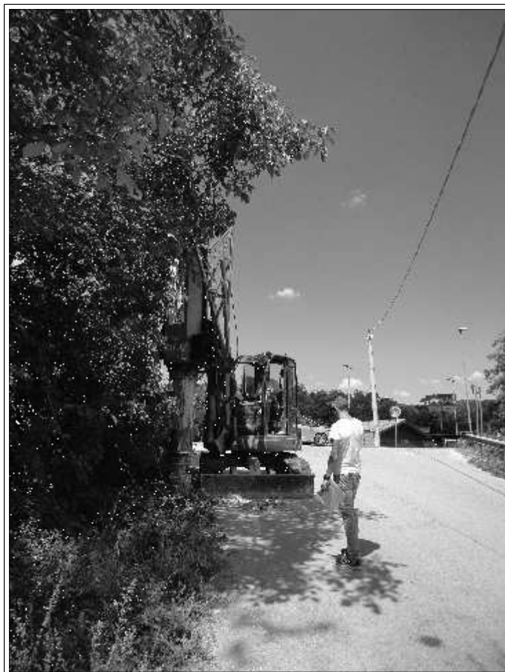
Foto n° 1 - Realizzazione sondaggio geognostico S1
